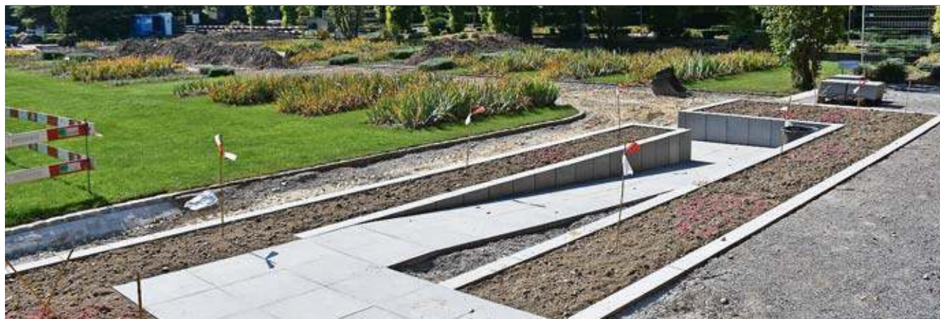
Die neue Rampe überwindet den Höhenunterschied schräg und nicht gerade.
